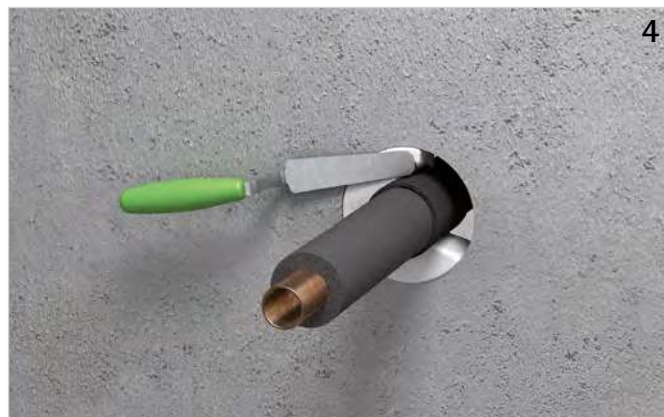
Ringspalt rauchgasdicht (mit z. B. Walraven Pacifyre® FPM Brandschutzmörtel) verschließen.
