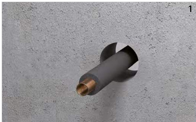
Rohrleitung mit Dämmung installieren.
