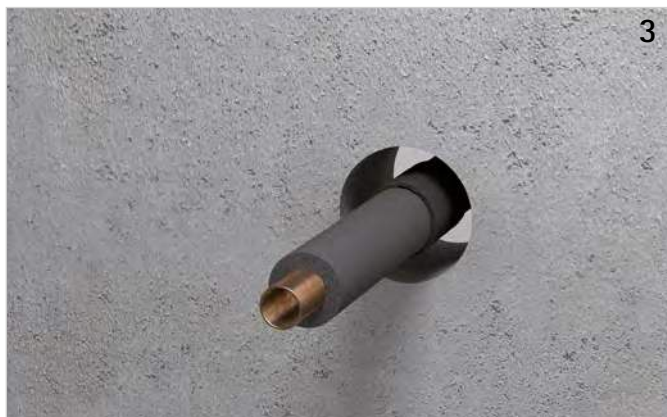
Rohrummantelung in die Bauteilöffnung schieben (Überstände beachten).
